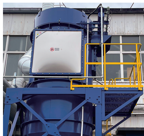
写真 3 ろ過式集じん機設置事例
