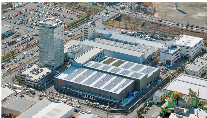
ホソカワミクロン大阪本社 (手前側が太陽光パネルを屋上に設置した新工場) Hosokawa Micron Osaka Headquarters (In front is seen the new Osaka Factory with solar panels installed on the roof).
