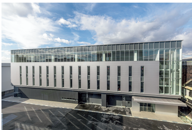
図1 新大阪工場（事務棟） Fig. 1 New Osaka Factory (Office Building)
