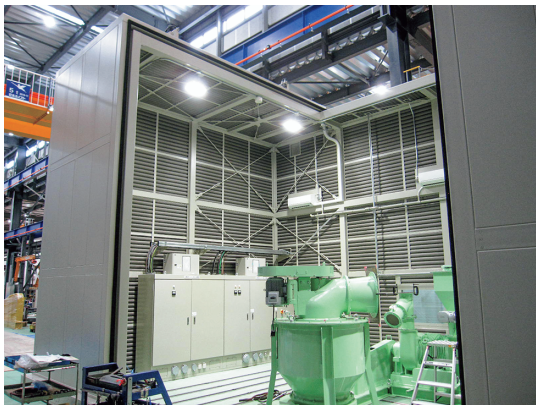
図4 試運転室 Fig. 4 Trail Operation Room
