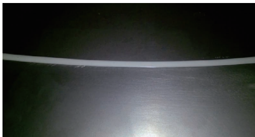
図8 機内から見たビッグドアのガスケット部 Fig. 8 Gasket part of Big Door seen from the inner vessel.
