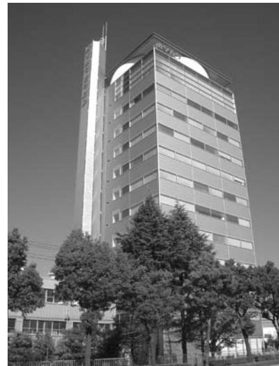
ホソカワミクロン(株) 大阪本社ビルとナノパーティクルテクノロジーセンター（左手）
