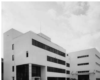
写真12 枚方技術開発センター（左手：実験室・事務棟，右手：テストセンター）
