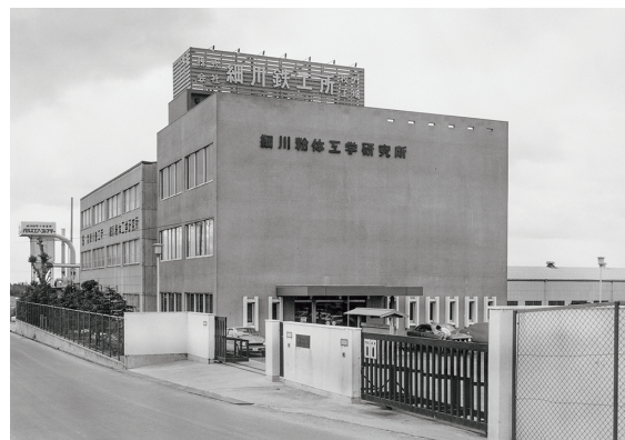
図4 枚方事業所に新しく建てられた粉体工学研究所(1968年完成)
