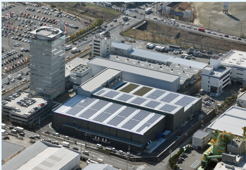
ホソカワミクロン大阪本社（手前側が太陽光パネルを屋上に設置した新工場）
