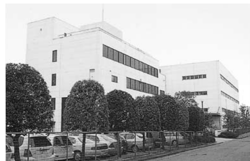
枚方技術開発センター(環境・エネルギーシステム開発部、製薬・美容科学研究センター他)
