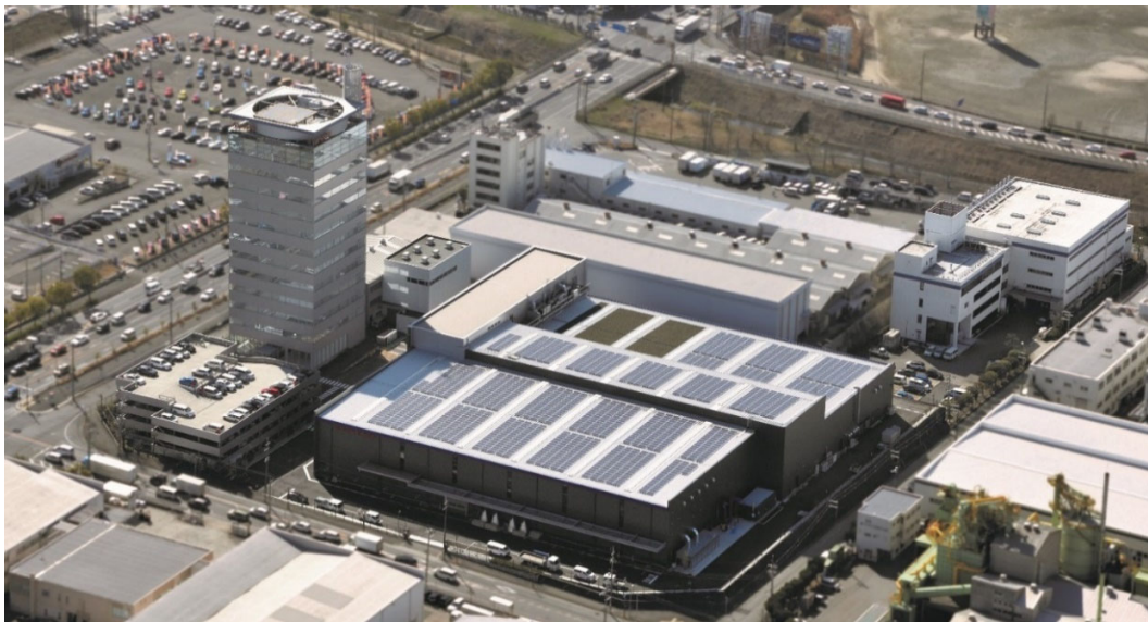
ホソカワミクロン大阪本社(手前側が太陽光パネルを屋上に設置した新工場)
