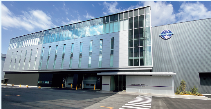
大阪新工場 外観写真
