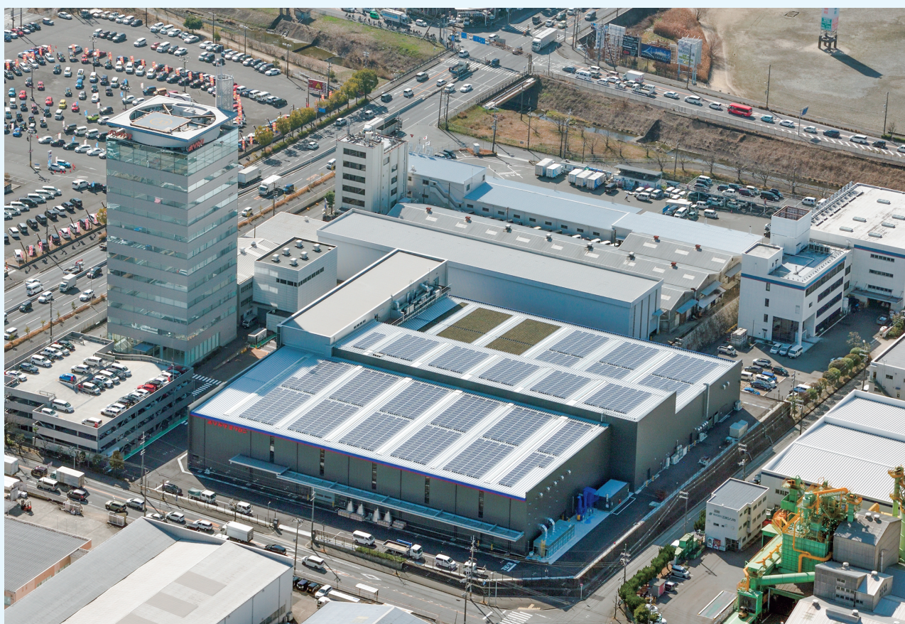
ホソカワミクロン大阪本社（手前側が太陽光パネルを屋上に設置した新工場）
